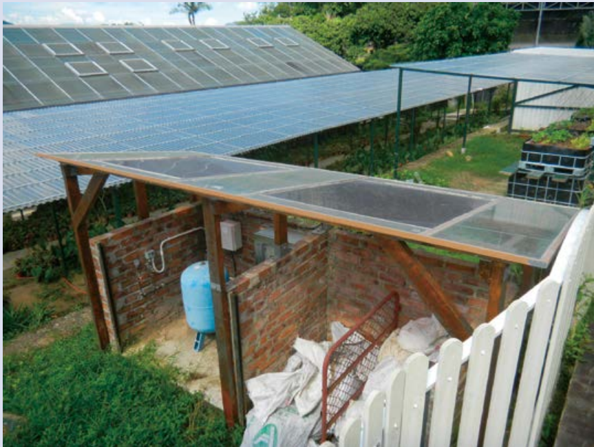
「一斗田」農圃上完成安裝「光伏系統之電能裝置」(BIPV)及相關電氣工程。
