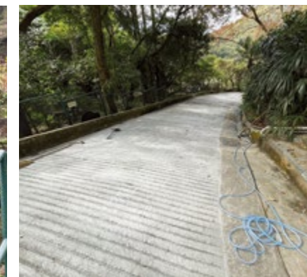
生態池附近車道以混凝土重新鋪設
