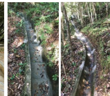
斜坡 7NW-C/C89 的維護工作
