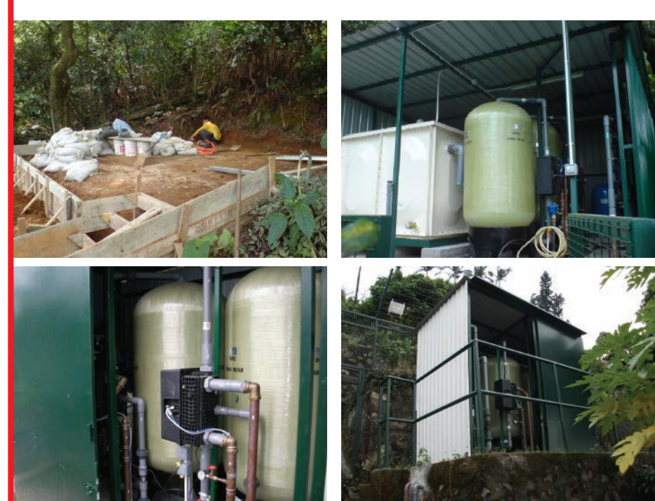
Set sedimentation tanks 裝置大型沉澱過濾系統
